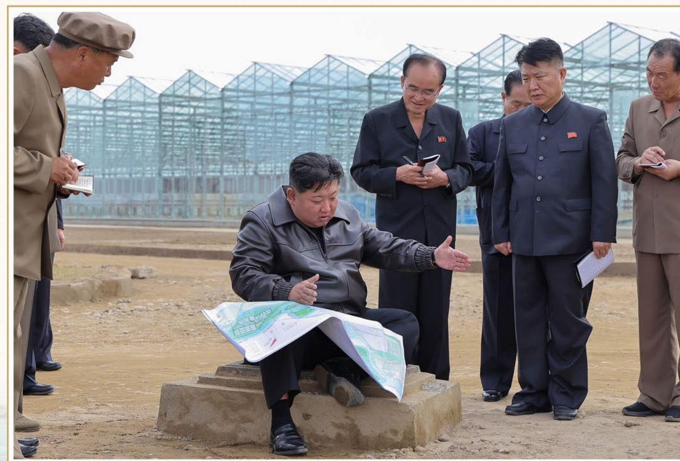
Kim Jong Un leitete den Bau der Komplexen Gewächshausfarm Sinuiju wieder vor Ort an. Oktober 2025
