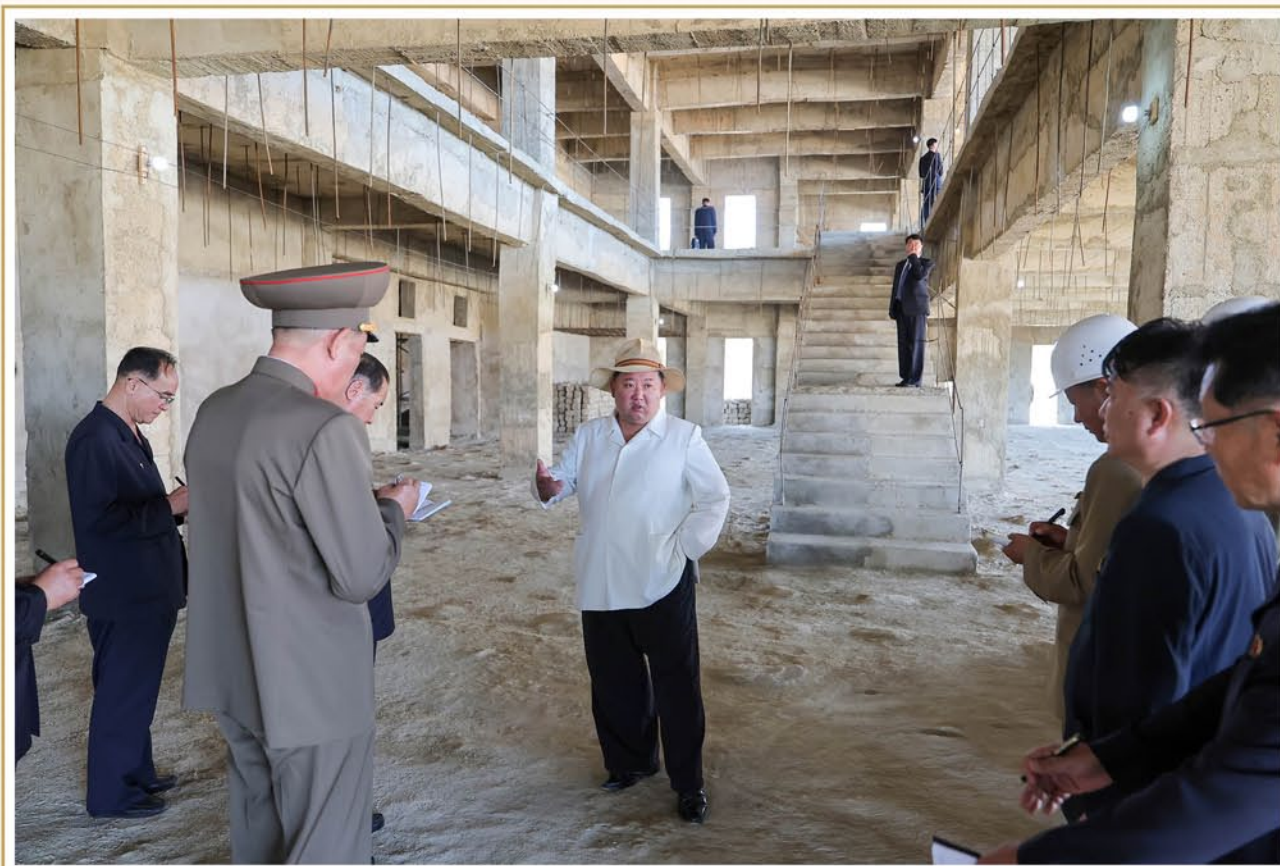
Kim Jong Un leitete die Baustelle für das Krankenhaus der Stadt Kusong vor Ort an. Juni 2025
