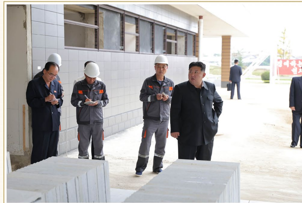
Kim Jong Un leitete die Baustelle für das Krankenhaus der Stadt Kusong vor Ort an. September 2025
